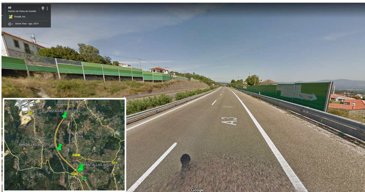
Figura 11. Pantallas acústicas na autopista portuguesa A3, prolongación da AP-9
