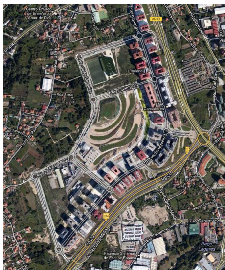
Figura 52 - Ortofoto do Plan Parcial, na confluencia das rondas VI-30 e a VG-20
