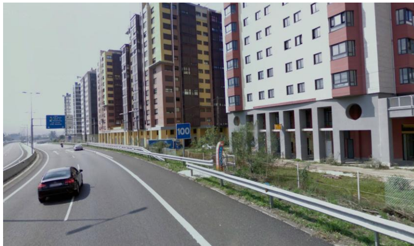
Figura 53 - Fotografía da VG-30 á altura do Plan Parcial. Carencia de elementos protectores, proximidade de edificios e gran velocidade de circulación
