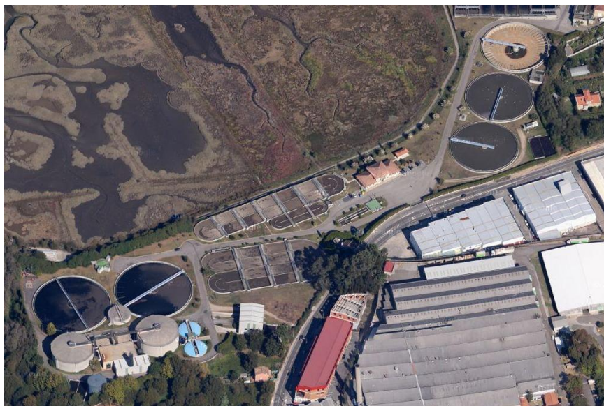
Figura 6 - Área de tratamento de augas industriais na zona de Navia. (fonte: Google Satellite)
