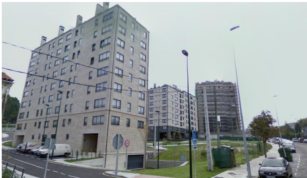
Figura 41 - Urbanización Rocío en la calle Tomás Paredes
